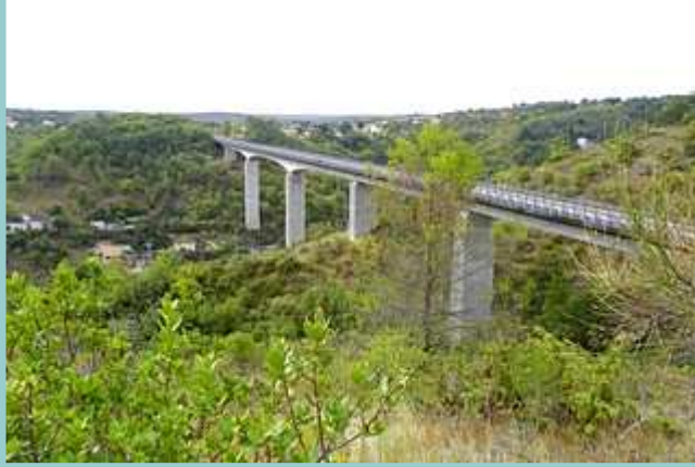
le viaduc de Roquebilière
