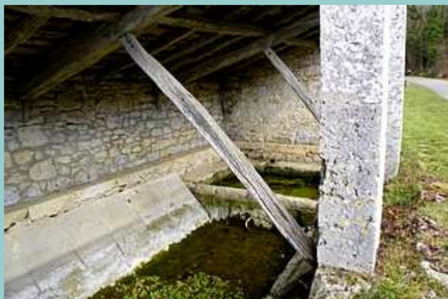
intérieur du lavoir
