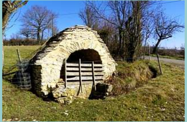
puits à Auliac
